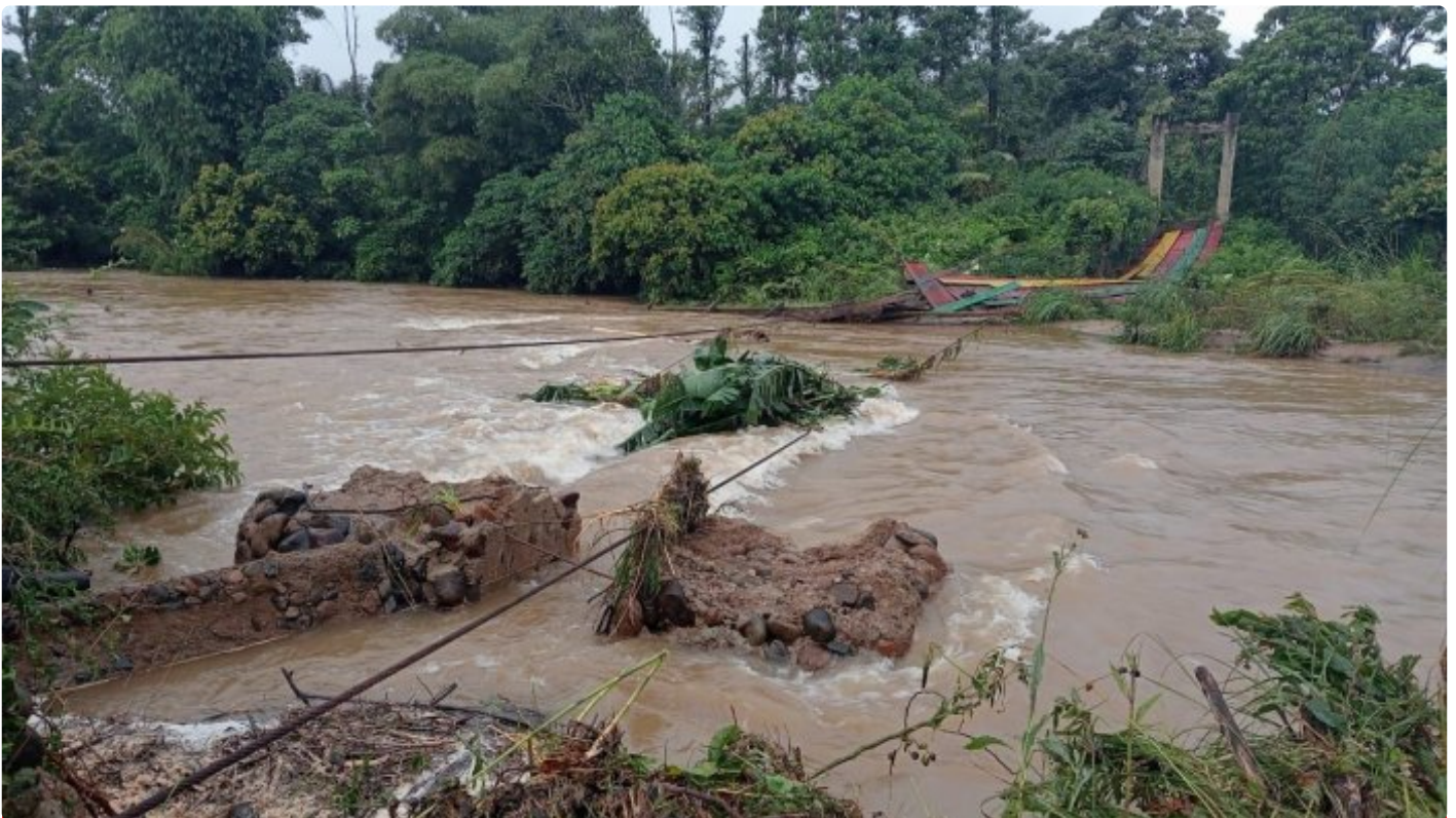
Foto: Jembatan penghubung Ibukota Kecamatan Rampi dan Desa Tedeboe
